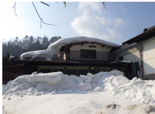
大雪で雪下ろしされない空き家
